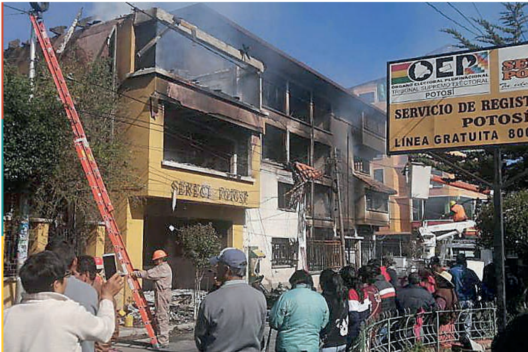
Consecuencias de la quema de las instalaciones del Sereci de Potosí
